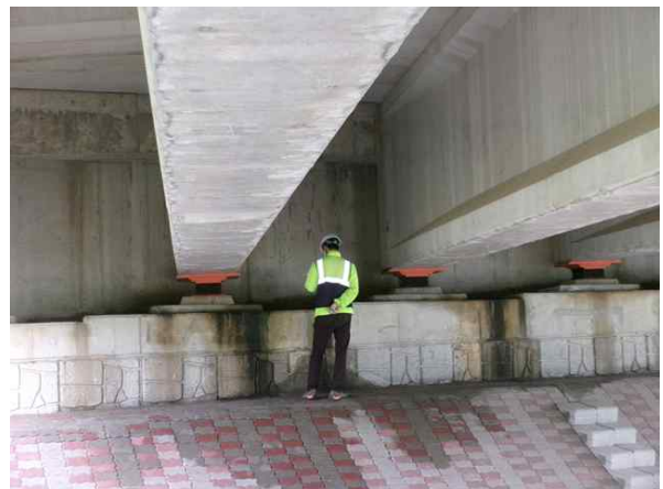
도보를 이용한 근접조사
